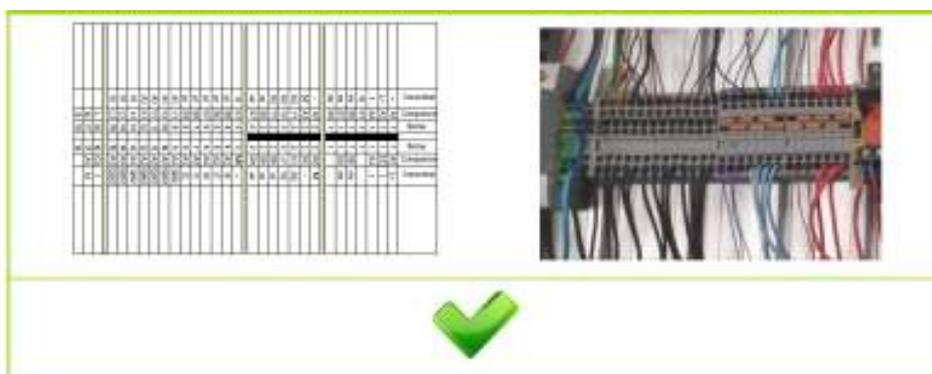
4.8 - Conformidade com o esquema elétrico (**instalação de acordo com o esquema elétrico fornecido**). Será verificado o endereçamento para a instalação dos componentes, como sua correta conexão com o PLC, botões de pressão, relé, fonte de alimentação, etc.
