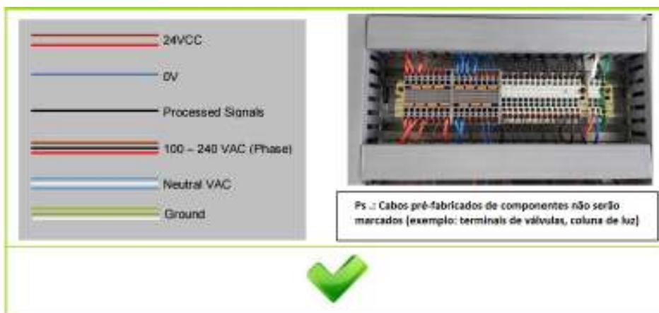
4.7 - Montagem correta do bloco de terminais. Serão verificadas as localizações de ligação dos componentes no bloco de terminais **de acordo com o esquema fornecido**.
