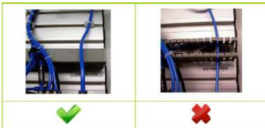
2 - FIXAÇÃO CORRETA DOS COMPONENTES (os componentes não devem estar soltos na Platina de montagem)
