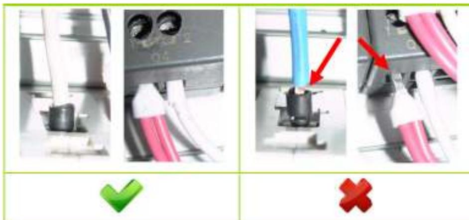
4.3 - O isolamento dos cabos deve ser removido para o interior da calha plástica. No exterior da calha plástica o isolamento só é permitido quando o cabo circular de uma calha plástica para a outra.
