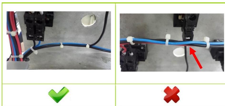
4.2. Correta fixação dos fios elétricos com ponteiros devidamente acopladas.
