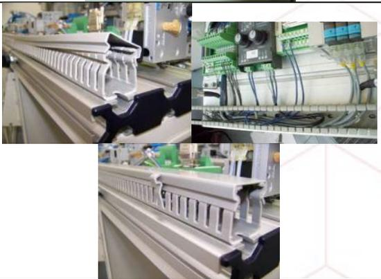
As pontas soltas ou não utilizadas, devem ser amarradas para atrás usando uma abraçadeira de fivela e devem ter o mesmo comprimento que as pontas usadas. No entanto o isolamento da alma condutora deve-se manter para evitar contatos desnecessários. Aplica-se dentro e fora das calhas plásticas.
